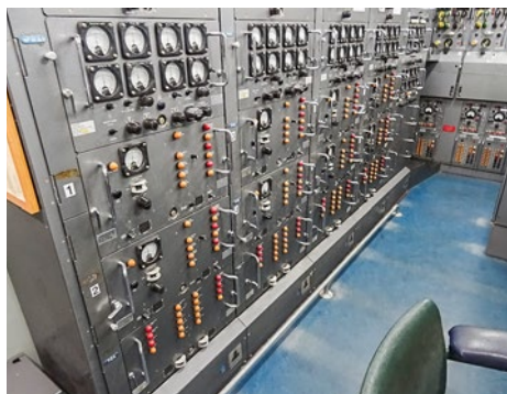
Enge Arbeitsplätze im Bunker
